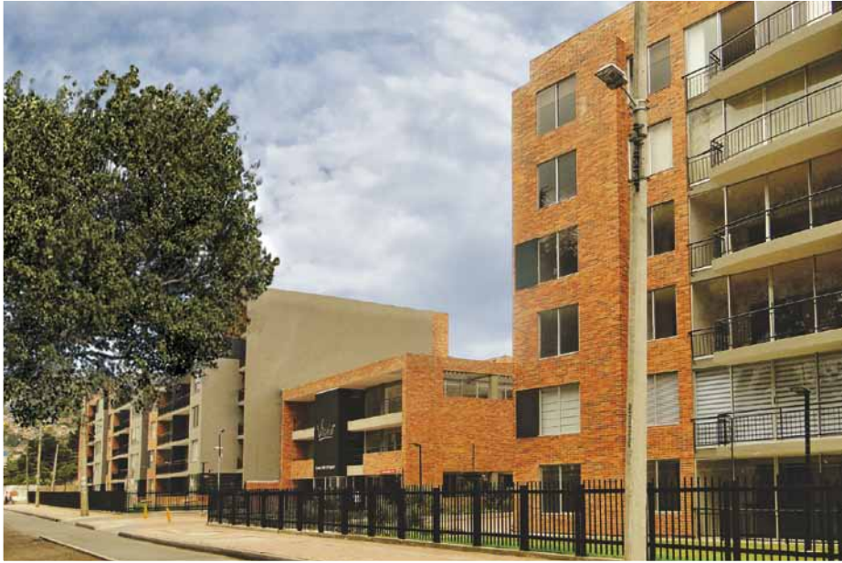
Vivaldi Etapa 3 Constructor: Coinsa Bogotá
