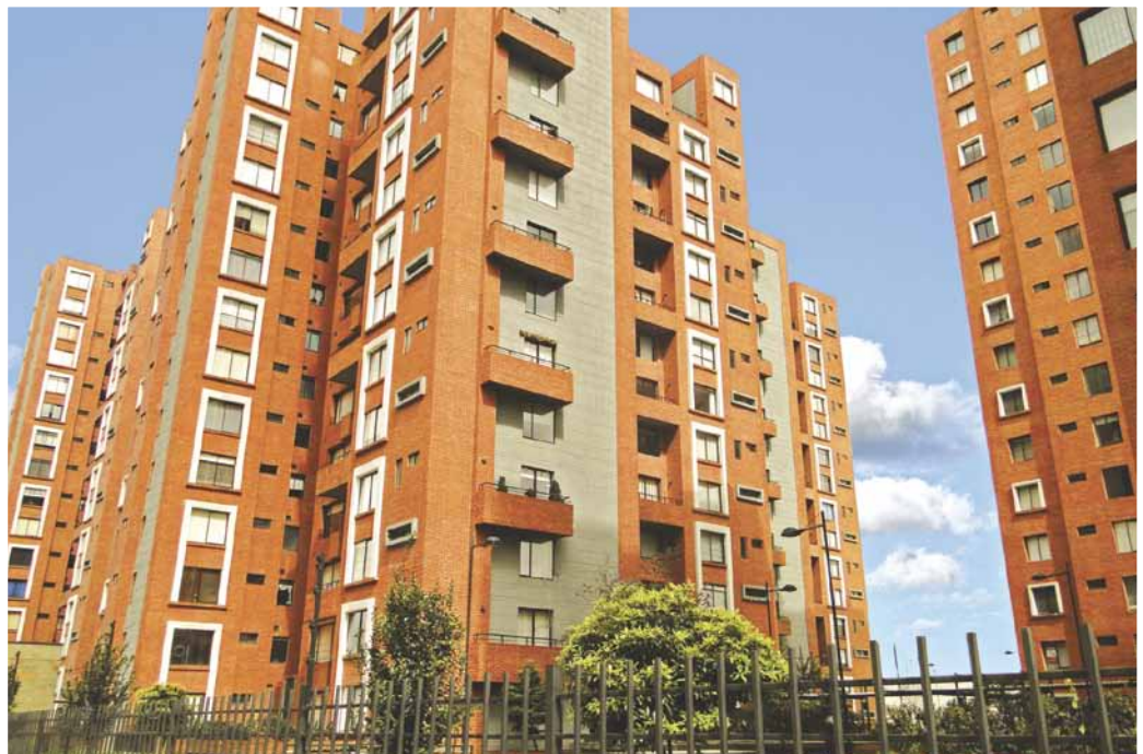
Salitre Alto Reservado Etapa 1 Constructor: Prodesa S.A. Bogotá
