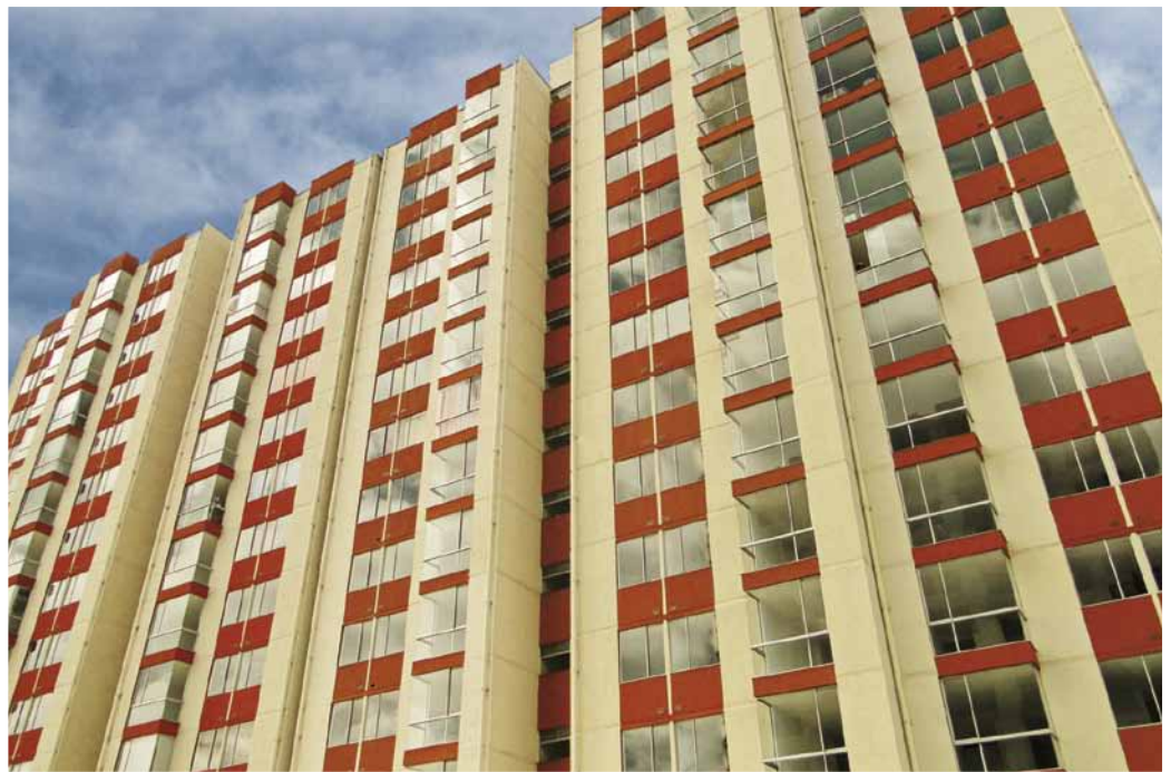
Gerona del Porvenir Etapa 1 (VIS) Constructor: Prabyc Ingenieros Ltda. Bogotá
