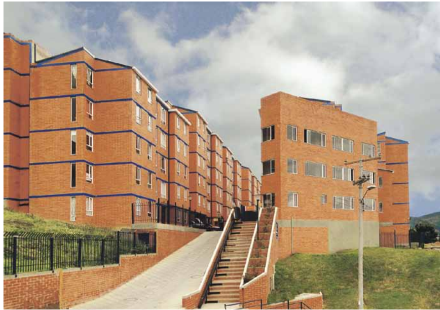
Colina Norte S5 Etapa II (VIS) Constructor: Promotora Convivienda Bogotá
