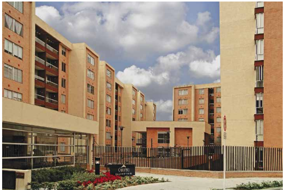
CaboPino Etapa II Constructor: Concreto / Espacios Inmobiliarios Bogotá
