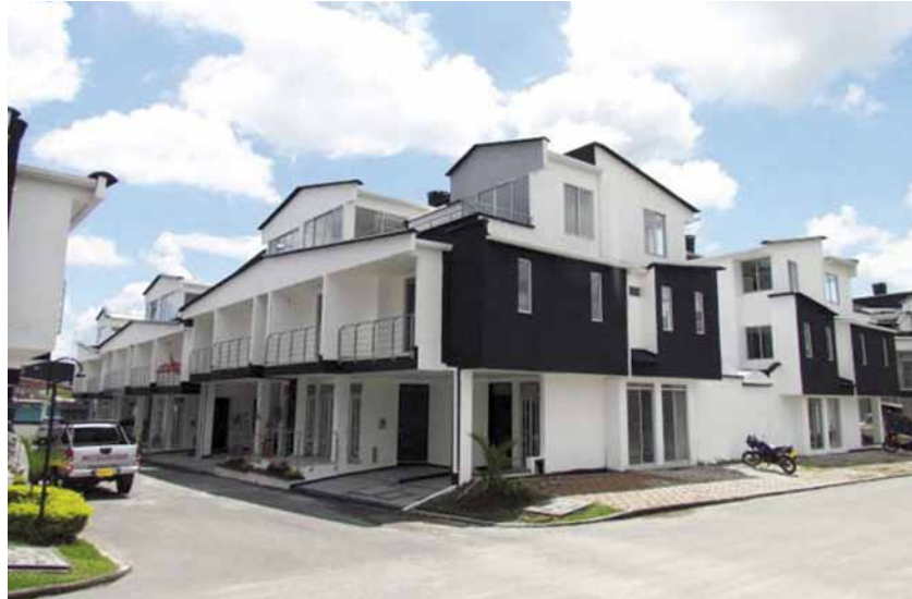
Condominio Ciudad del Campo Etapa I Construcciones Ferglad y Cía. Ltda. Villavicencio
