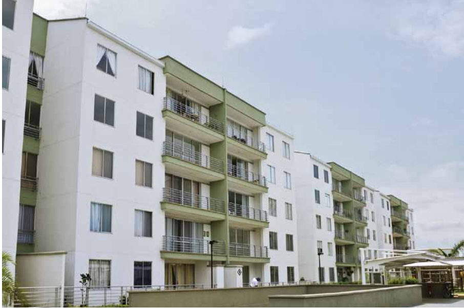
Portal de Toledo Constructora Bolívar Cali S.A. Cali
