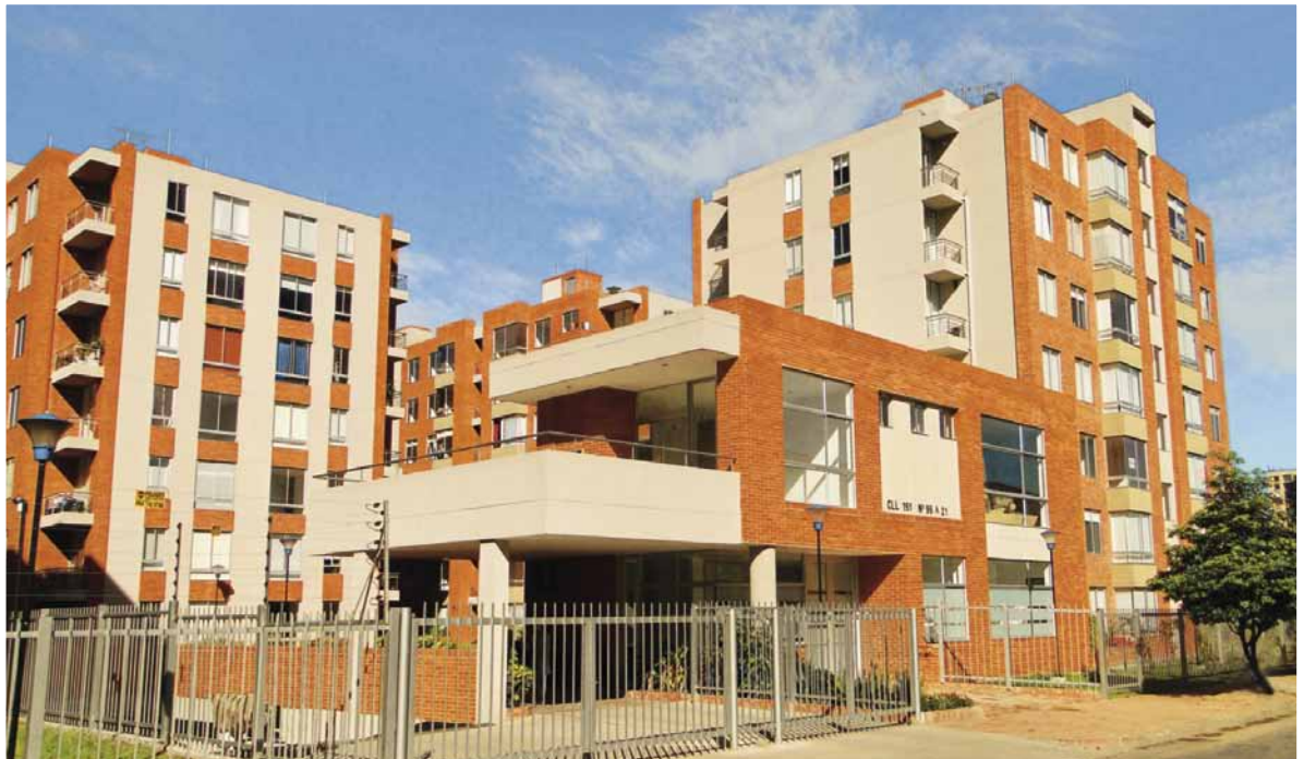
Salerno Constructor: Urbe Capital S.A. Bogotá
