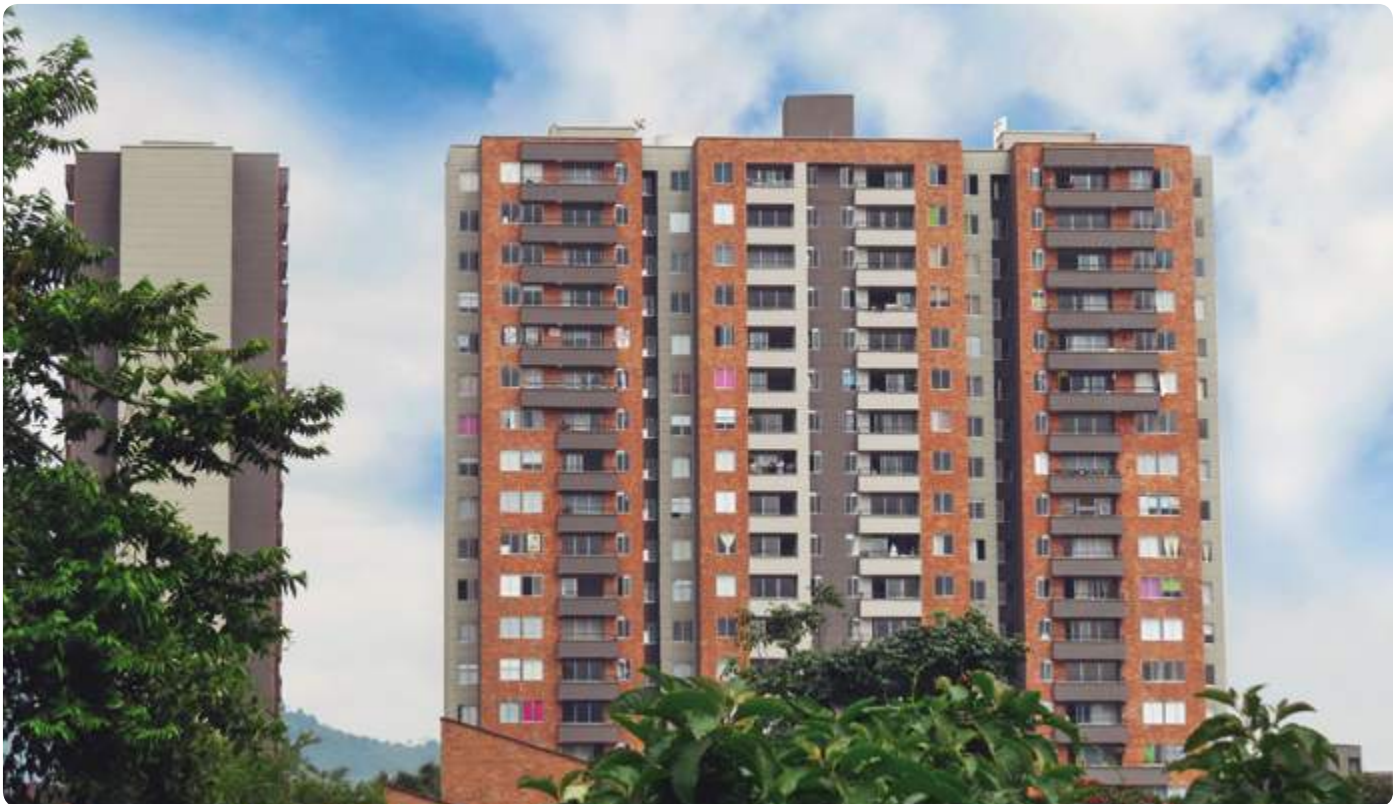
PITRIZA Constructor: CONSTRUCTORA CAPITAL MEDELLÍN S.A.S. La Estrella, Antioquia
