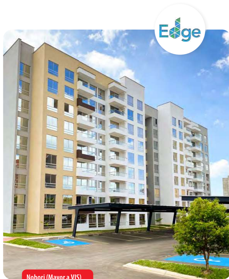
Nobori (Mayor a VIS) Constructora Asul S.A.S. Pereira
