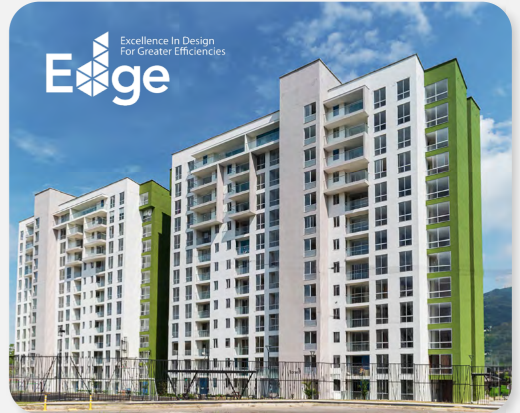
Olmo / Mayor a VIS Certificado Edge Núcleo Constructora S.A.S. Dosquebradas, Risaralda
